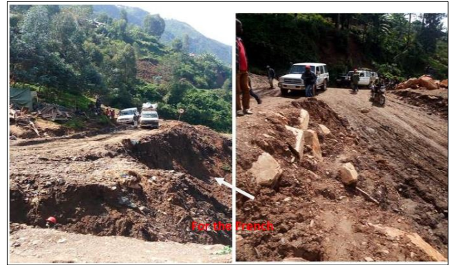
Fig 9: Subsidence zone at Nyabibwe Chez les Français
